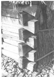
Рис. 112. Тип углового сопряжения. Начало XX в. Д. Луково Малоритского р-на Брестской обл.
