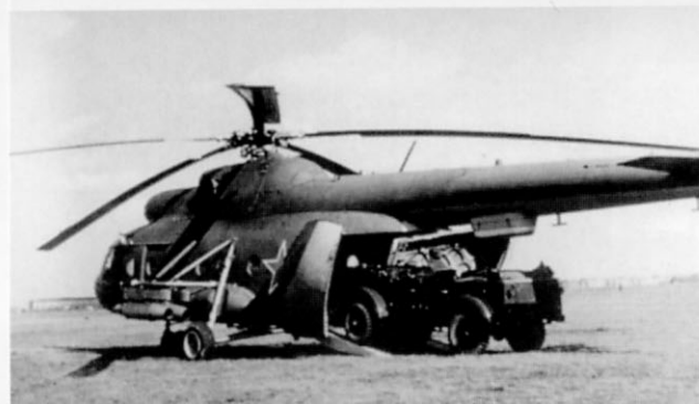
Загрузка автомобиля ГАЗ-69 в вертолет в ходе испытаний
